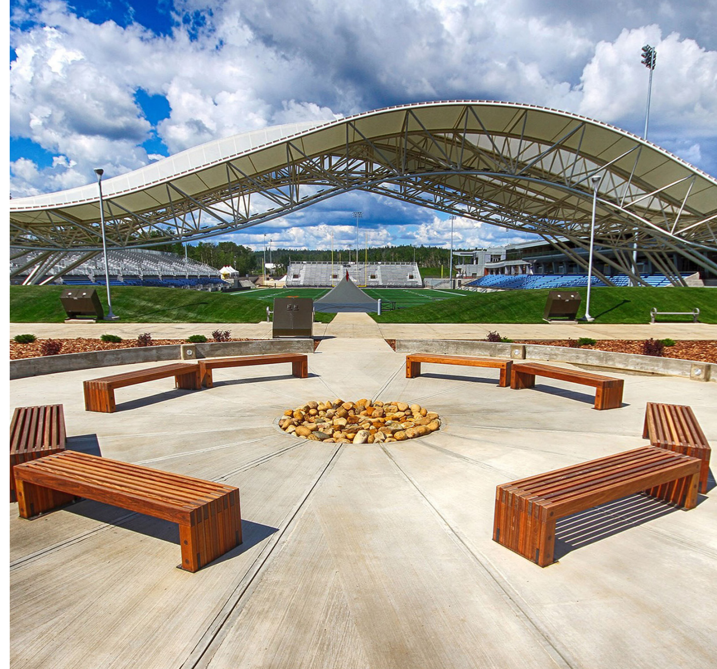
Shell Place, complesso sportivo ad uso misto in Canada, progettato da Stantec.
